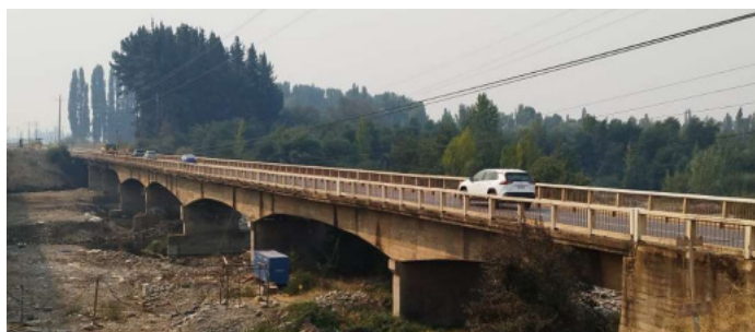
Figura 2. Vista general puente Santa Isabel (Soto y Díaz, 2023)
