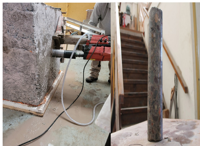
Figura 6. Testigo extraído del bloque de hormigón masivo.
