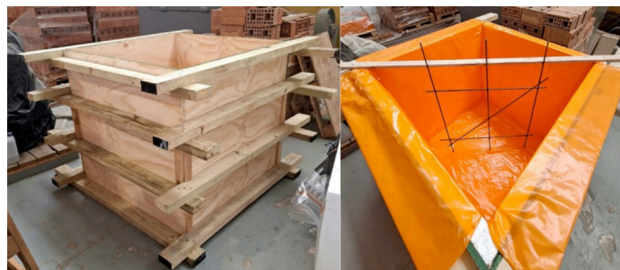
Figura 2. Moldaje para la confección del bloque de hormigón masivo.
