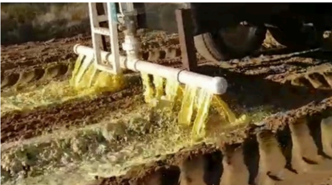
Figura 5: Distribución en obra de la dilución de desgomado de soja
