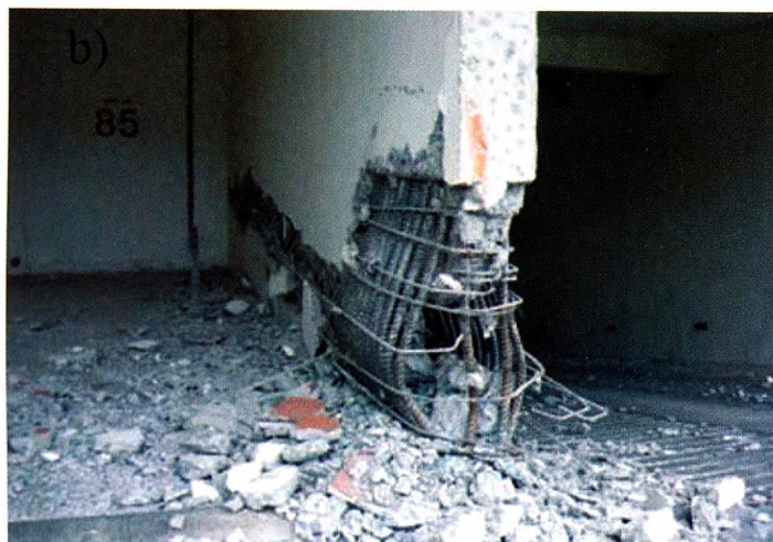
Figura 2: Muro de estacionamiento de primer piso edificio de 17 pisos
