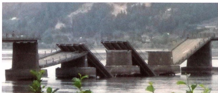
Figura 22: Colapso de tableros y cepas del Puente Viejo sobre el río Bío Bío
