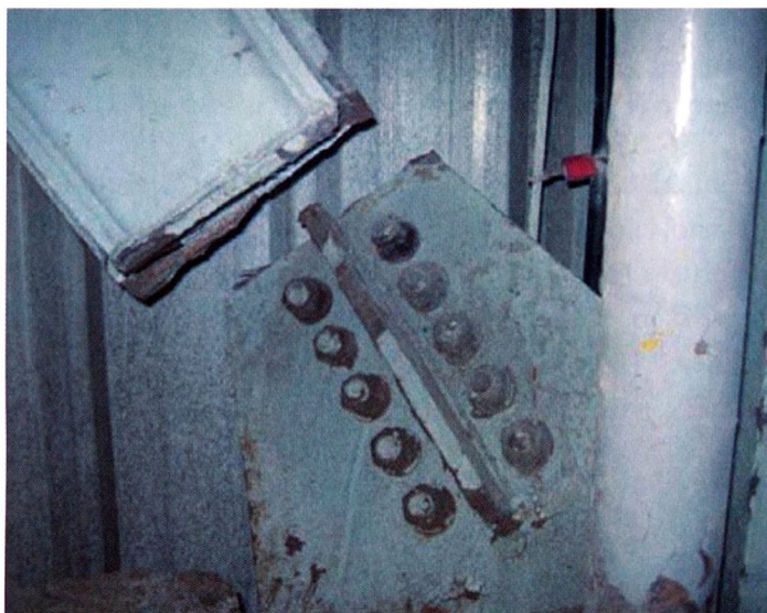
Figura 16: Falla frágil en diagonal sísmica (tomado de Hidalgo 2010)
