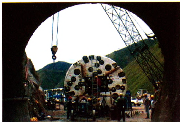
Figura 6: Montaje de la TBM Proyecto Chimay, Perú.
