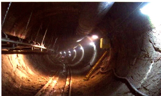
Figura 17: Tramo del túnel en roca de buena calidad (sólo pernos puntuales en la bóveda)
