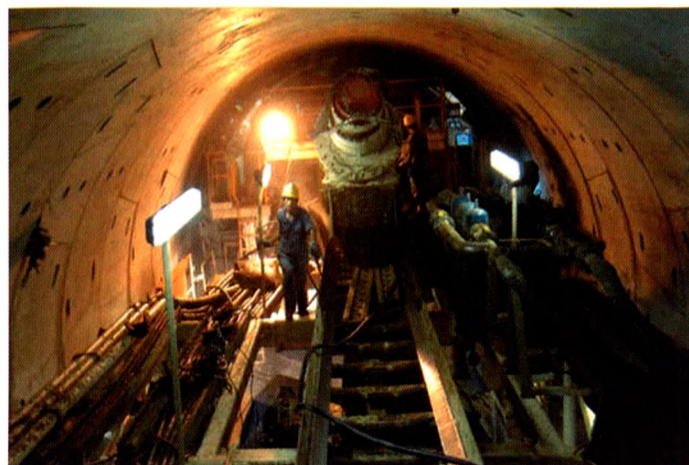
Figura 10: Vista de uno de los túneles del Arroyo Maldonado, justo atrás de la TBM. Se puede observar el revestimiento en base a dovelas prefabricadas de hormigón
