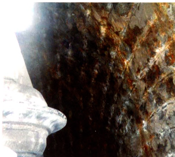
Figura 18: Tramo del túnel en roca de buena calidad (sólo pernos puntuales en la bóveda)
