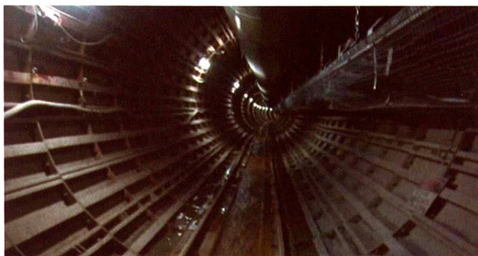
Figura 16: Tramo del túnel donde se aprecia el sostenimiento con dovelas metálicas en una zona con macizo rocoso de mala calidad geomecánica. En el extremo superior derecho se observa la cinta transportadora.
