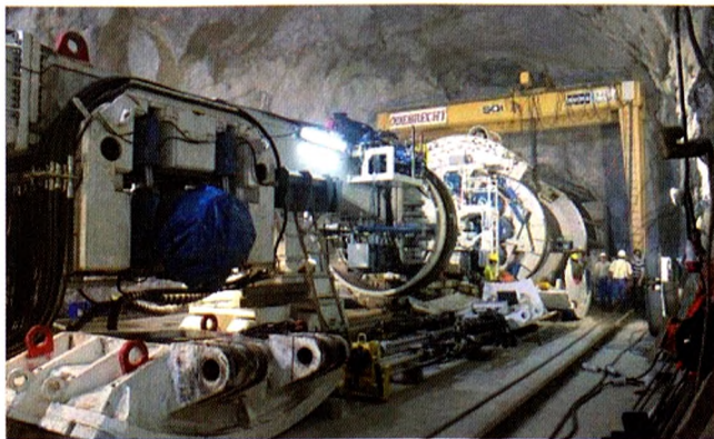
Figura 9: Montaje subterráneo de la cabeza de corte de la TBM abierta Robbins del túnel de trasvase de Olmos, Perú
