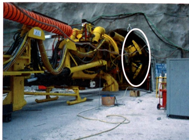
Figura 20: Open TBM ingresando al túnel de arranque. Se pueden visualizar los gripper en forma de X de Wirth en el óvalo de color blanco (Tunnel Talk 2010)
