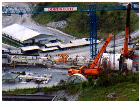
Figura 8: Montaje TBM Doble Escudo Central Hidroeléctrica San Francisco, Ecuador.
