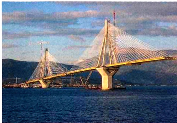
Fig. 17 Puente Rion-Antirión, Grecia [Foto: Cortesía de FIP Industriale, Italia]
