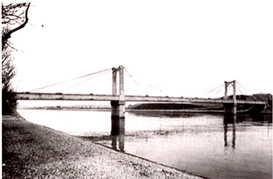
Fig. 4 Puente sobre el canal Donzère, Francia. [Foto: J. Kerisel]
