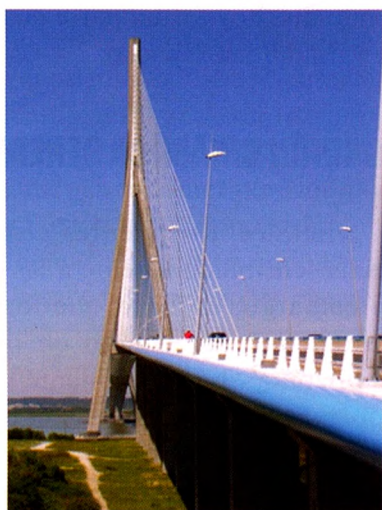
Fig. 9 Puente de Normandía, Francia [de fr.structurae.de]
