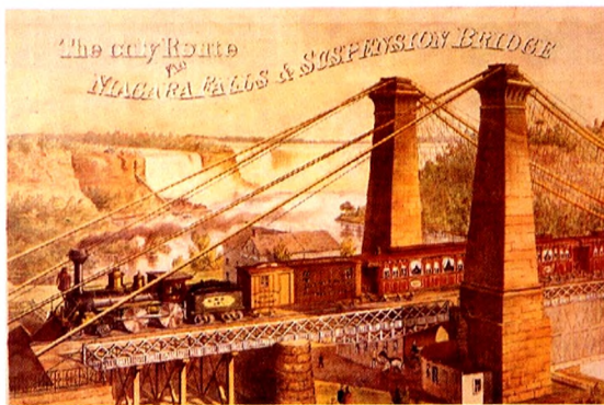
Fig. 2 Puente Niagara Falls, EEUU [Cortesía de la Comisión de Puentes de Niagara Falls]
