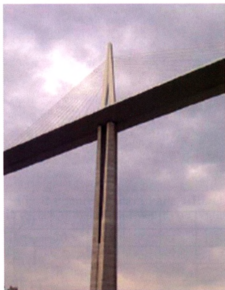
Fig. 12 Viaducto de Millau, Francia [Foto: G. Valdebenito]
