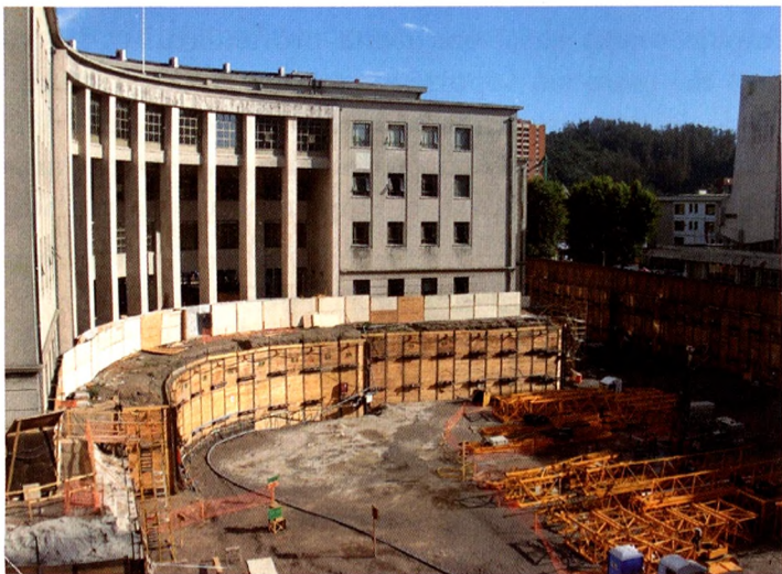
Figura 5: Vista del muro Berlinés curvo apegado a los Tribunales de Justicia
