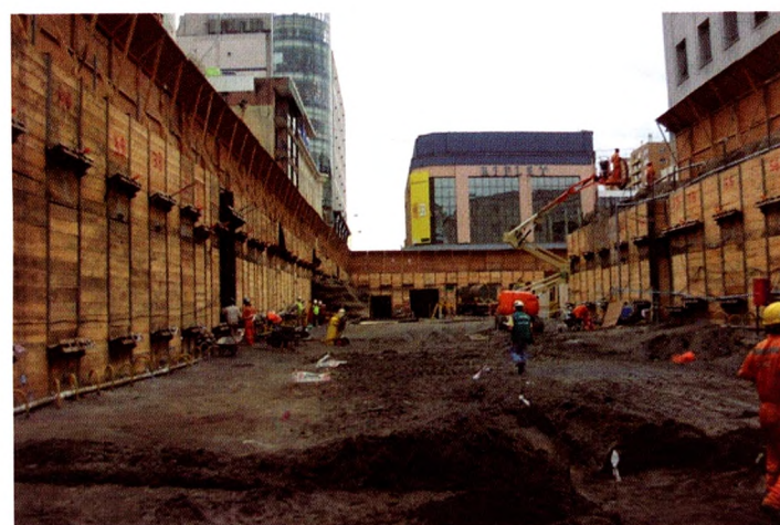
Figura 13: Vista parcial de la excavación del proyecto de estacionamientos subterráneos
