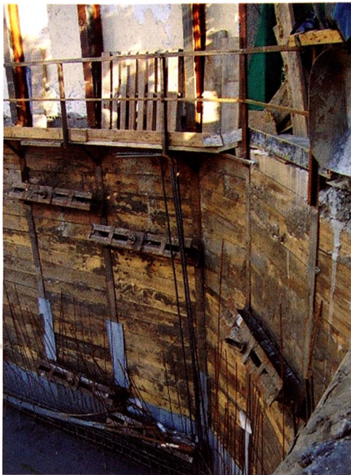
Figura 8: Detalle vigas de amarre a diferentes niveles
