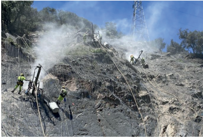
Figura 1: Dificultades en la instalación de pernos de anclaje (cortesía: www.inaces.com )
