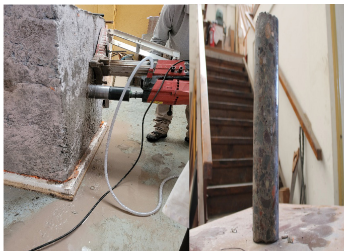
Figura 6. Testigo extraído del bloque de hormigón masivo.
